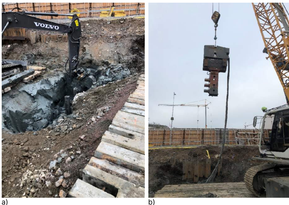
Figur 4.1. Framschaktning av pålar samt kran med greppanordning och vibrator.
