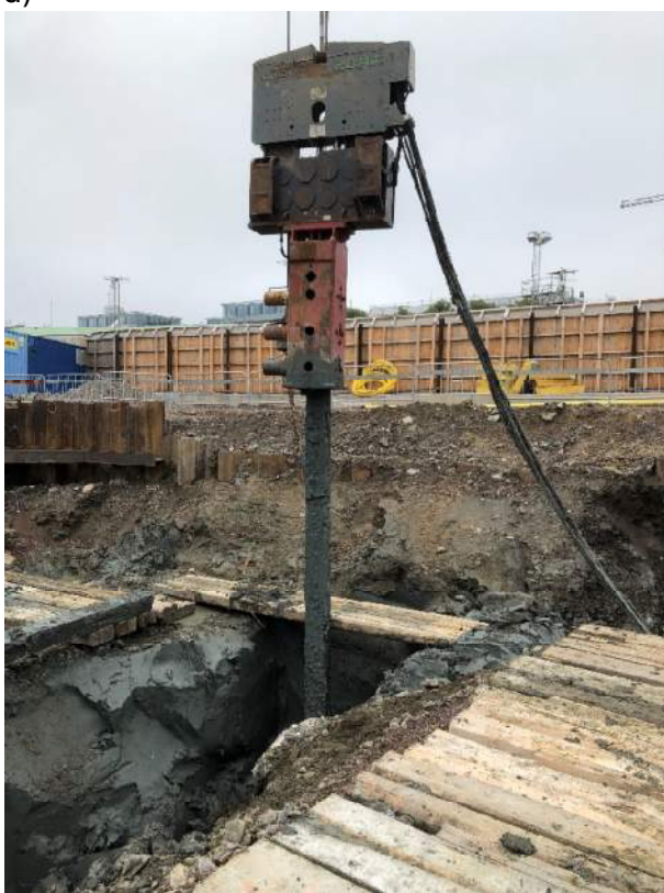
Figur 4.2. Kran, vibrator, greppanordning samt foton som beskriver uppdragning av påle.
