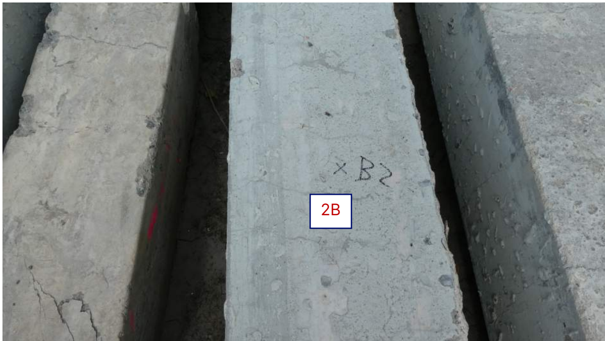
Figur 5.3. Foto på påle 2B. Kärna utborrad från formsida vid gjutning
